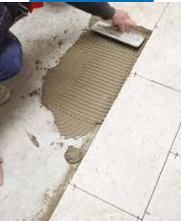
Pose de grès cérame porcelainé avec Keraflex Maxi S1 zero
