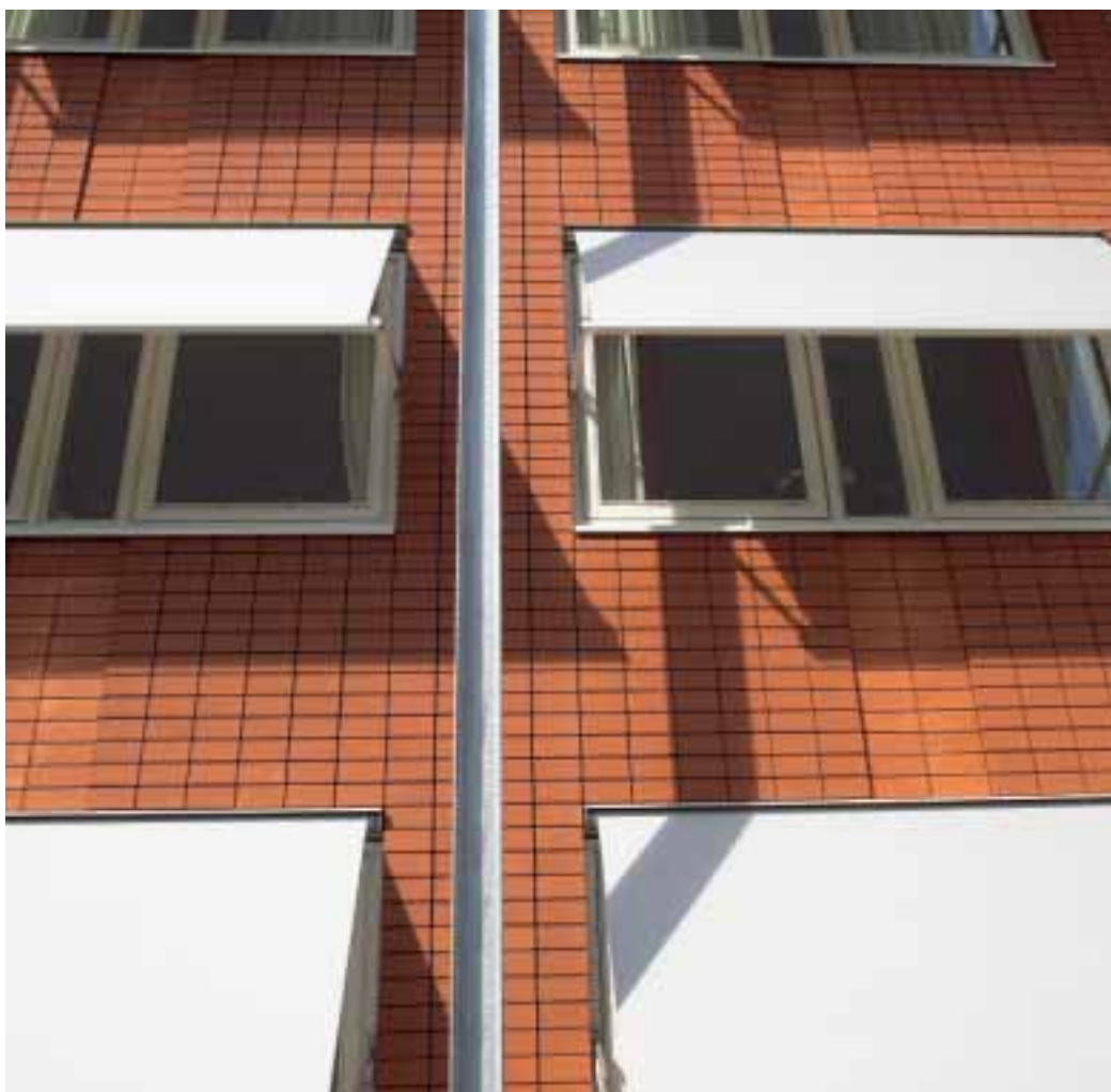
Appareillage en pose carrelage
