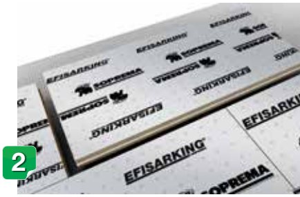
2 Pose à joints croisés de l'isolant.
