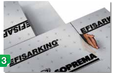
3 Les coupes sont réalisées à la scie.
